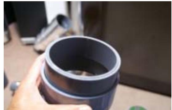
4 インチ取り付けのため径の拡大をします VP100 を2本径つめて2重です
